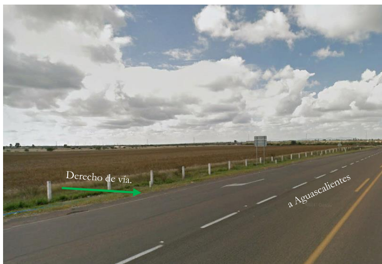
Ilustración IV.22 Derecho de vía de la carretera federal No.70 por dónde pasará la Línea de Transmisión de 400 kV (21° 49' 38.78" N y 102° 7' 14.71").
